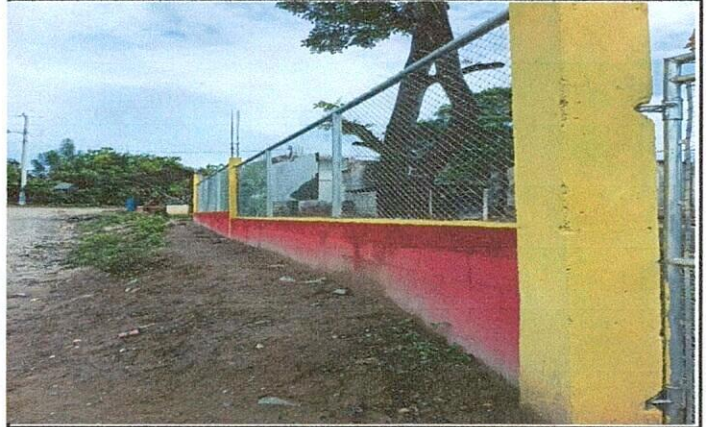
Foto 2: mejoramiento a muro perimetral finalizado
