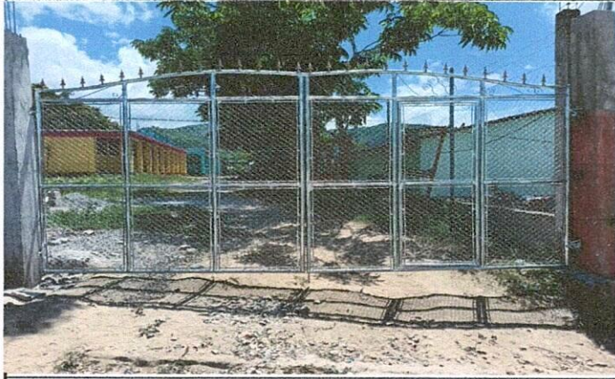
Foto 1: Mejoramiento a portón de ingreso finalizado
