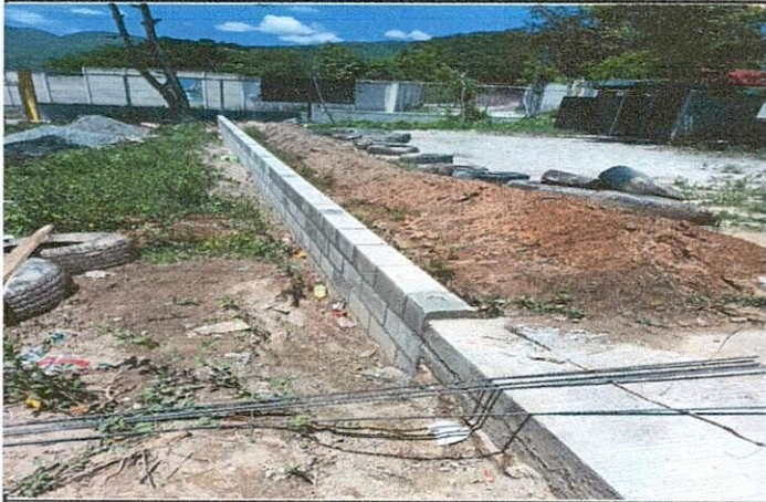
Foto 3: Mejoramiento muro de contención finalizado
